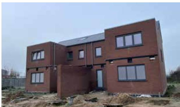
EVERGEM/ERTVELDE, HOGE WAL: 6 woningen – ARKS Architecten
