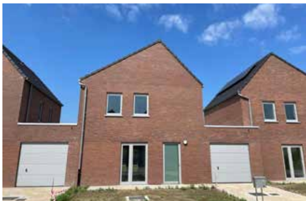
Nieuwbouw van 9 woningen – Buro 56
