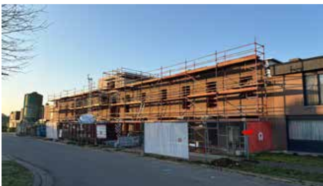
Vervangingsbouw van 12 woningen naar 21 appartementen – Design & Build met Damman
