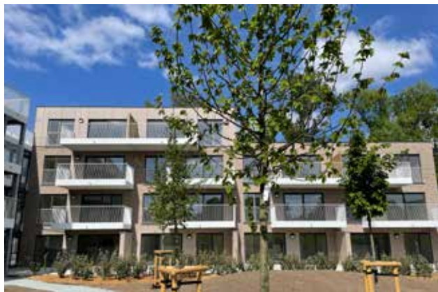
Nieuwbouw van 25 appartementen – Claeys Architectuurbureau
